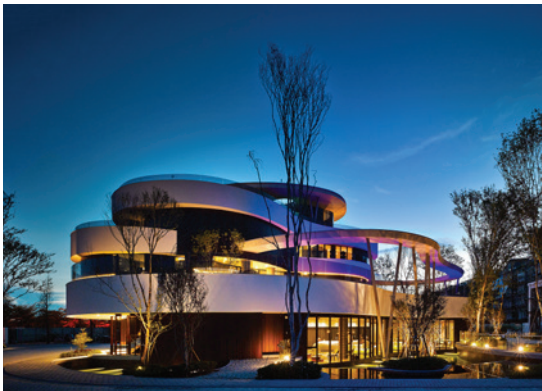
Des projets architecturaux renommés sont équipés de cuisines LEICHT à travers le monde – ici un club-house exclusif à Taïnan/Taiwan. LEICHT présente de nombreux projets tels que celui-ci dans sa publication « Architecture+Cuisine ». Photo : LEICHT
